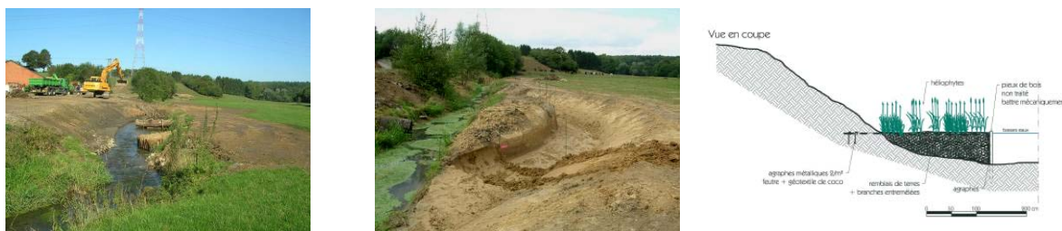
Figure 4 : Chantier, reméandrage et banquette végétalisée sur le Leignon à Haljoux (chantier DCENN Namur – août 2010)
