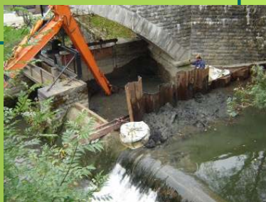
Travaux de la passe à poissons à Yvoir
