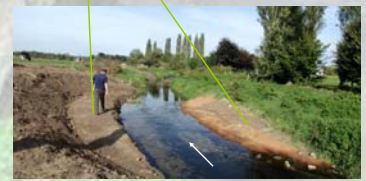
Réalisation d'une banquette en rive gauche et d'une risberme plantée d'hélophytes en rive droite
