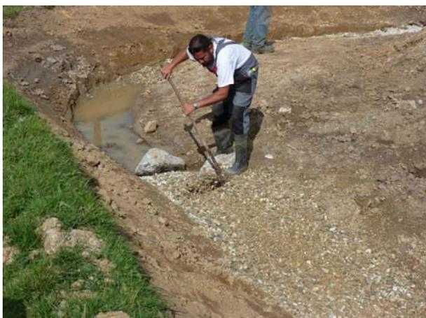
Photo 7: Mise en place du gravier roulé
