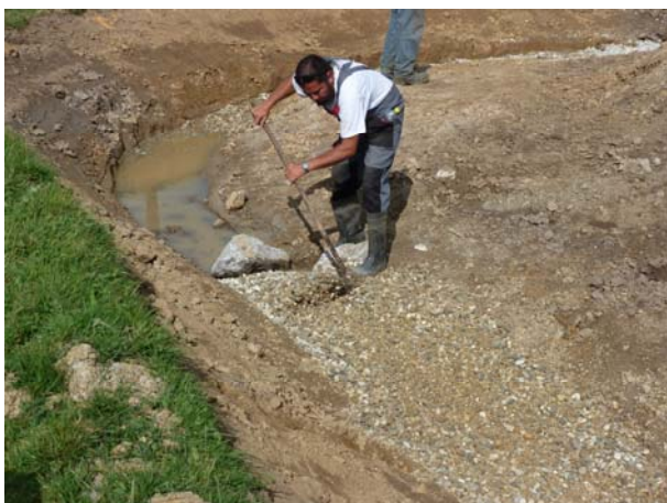
Photo 7: Mise en place du gravier roulé
