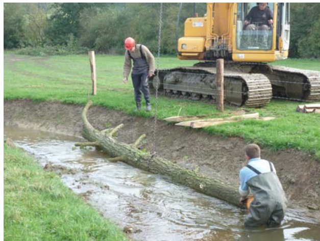
Photo 10: Mise en place de troncs
