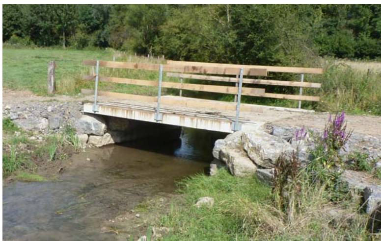
Photo 11: Passerelle pour charroi agricole
