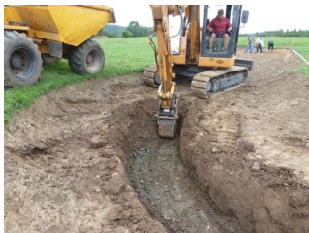
Photo 6: Déblai du chenal d'étiage
