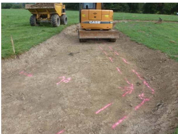
Photo 5: Déblai des banquettes latérales
