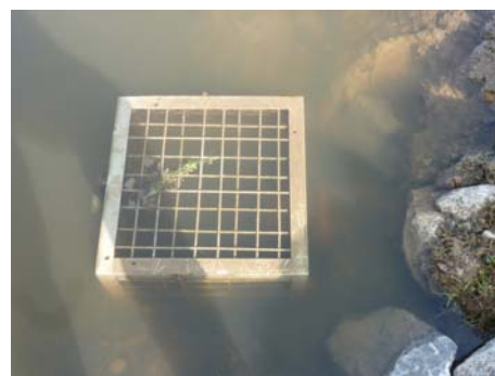
Photo 8: Prise d'eau de l'orifice noyé
