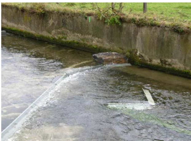
Photo 4: Détail des cornières en acier
