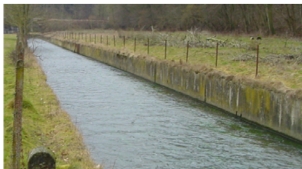
Photo 1: Secteur amont avant travaux de réhabilitation
