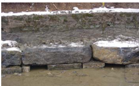
Photo 8: Caches à poissons au pied du mur de la berge gauche
