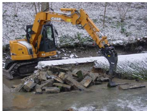
Photo 3: Démolition de l'ouvrage
