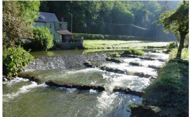
Photo 4: Dispositif en pré-barrages (vue vers l'amont)
