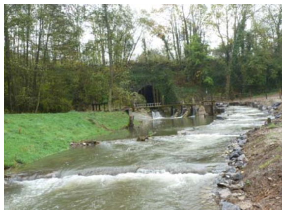
Photo 1: Dispositif hybride sur le Bocq à Braibant, alliant des pré-barrages et une rivière de contournement
