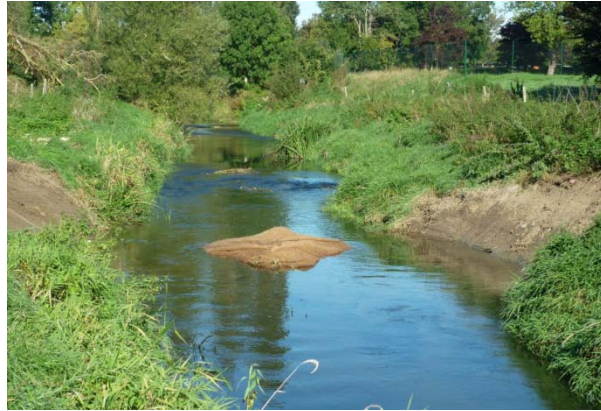
Déflecteurs et injection de galets
